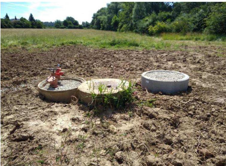
Figure 5 : Borne d'irrigation agricole, regard de sectionnement et buse avec vanne de vidange
